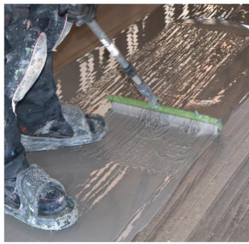
Acrylharz lässt sich auch bei Minusgraden verarbeiten und ist in einer Stunde ausgehärtet.
