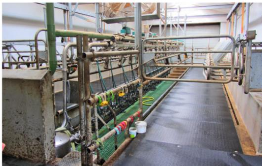
In diesem steilen Fischgrätenmelkstand wurden Gummibeläge nachgerüstet, um den starken Klauenabrieb durch den Epoxidharzboden zu vermindern.
