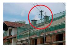
■ Über dem Dach verlaufende Stromleitungen müssen im Arbeitsbereich ausreichend isoliert sein.
